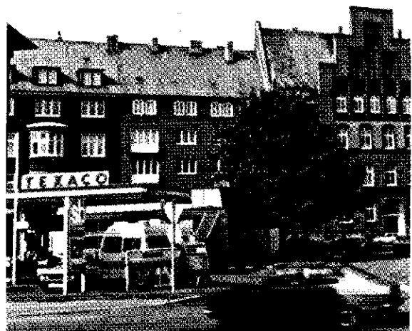
Tankstelle auf dem Grundstück der Höheren Töcherschule
