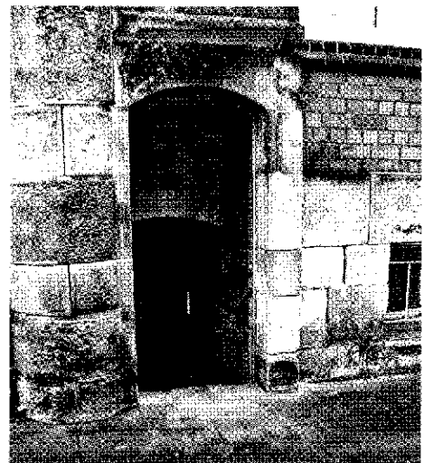
Eingang ehemaliger Milchladen im Pfarr- und Gemeindehaus
