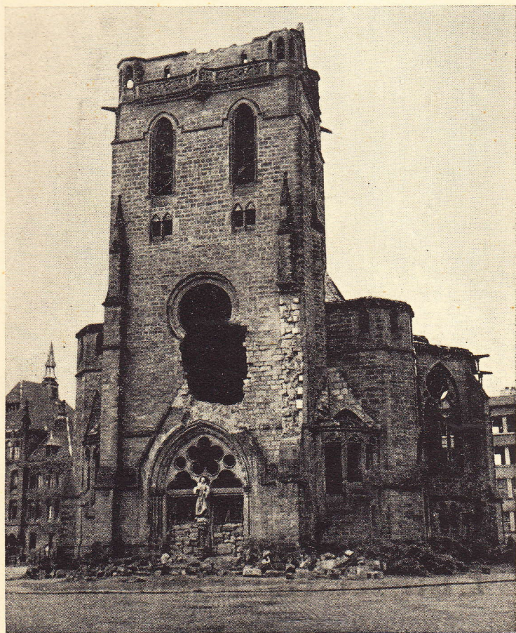
Die Lutherkirche nach der Zerstörung an Palmarum 1945
