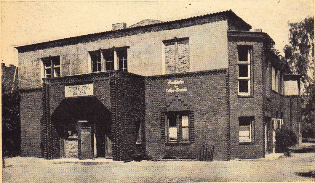
Saalkirche und Gemeindehaus
